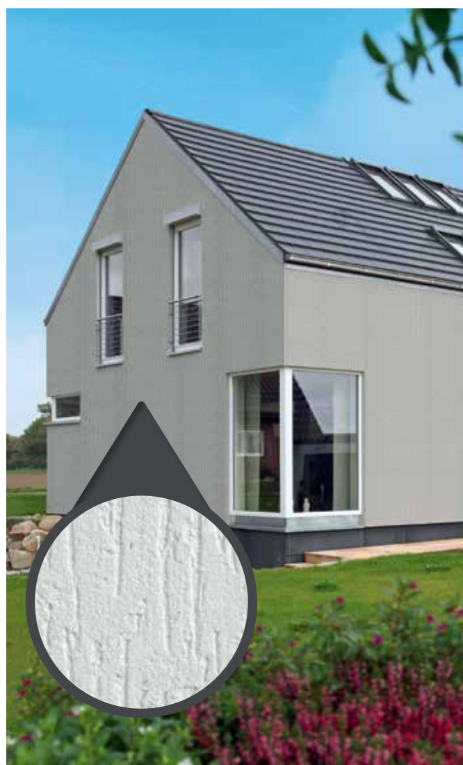
Structură de tip R - zgâriată
