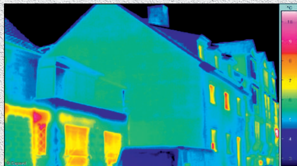
Imaginea 2. Indică termografia aceleiași case după montarea unui sistem profesional termoizolant.
